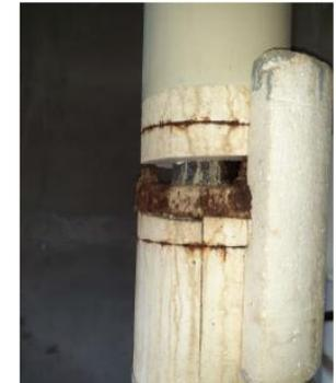
Conduites corrodées et traces d'infiltration / fuite
